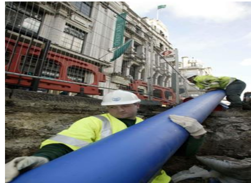
图 13: 市场化机制下修建污水管网等配套设施
