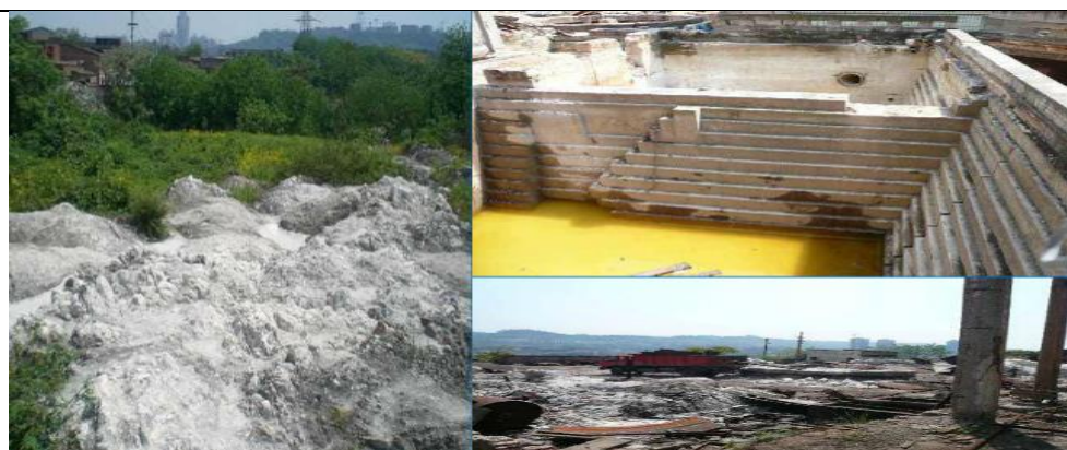
图 1 搬迁后土壤污染的场地地面
