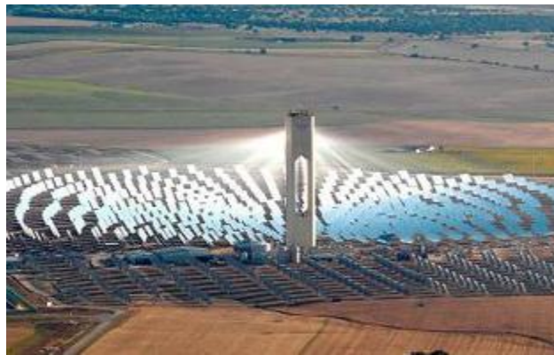
图 10: 塔式光热电站实景图
