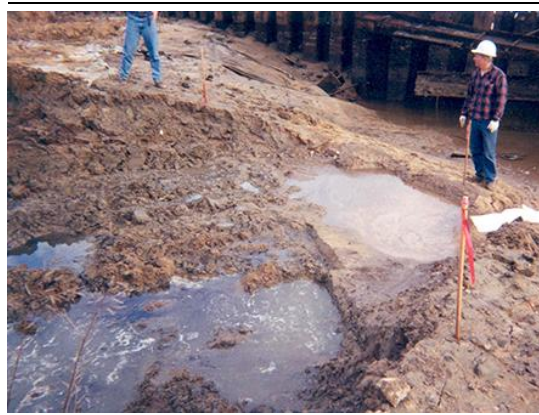
图 26: 棕地修复现场 IST 工程师监督施工
