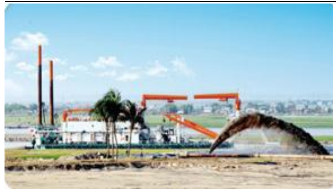
图25 孟加拉国帕德玛大桥河道整治项目
