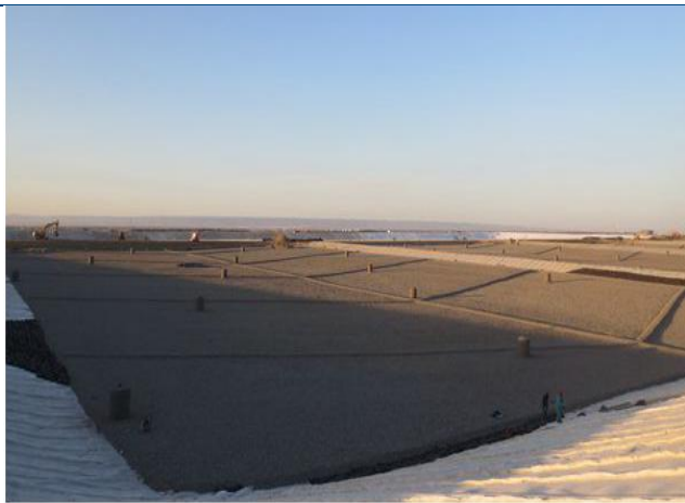
图 2: 公司承做的克拉玛依生活垃圾填埋场二期工程
