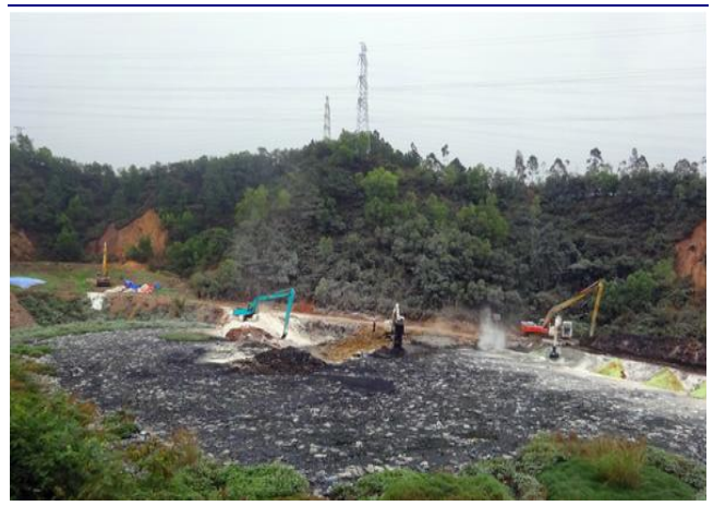
图 3: 珠海市沥溪垃圾填埋场封场及污泥坑综合治理工程
