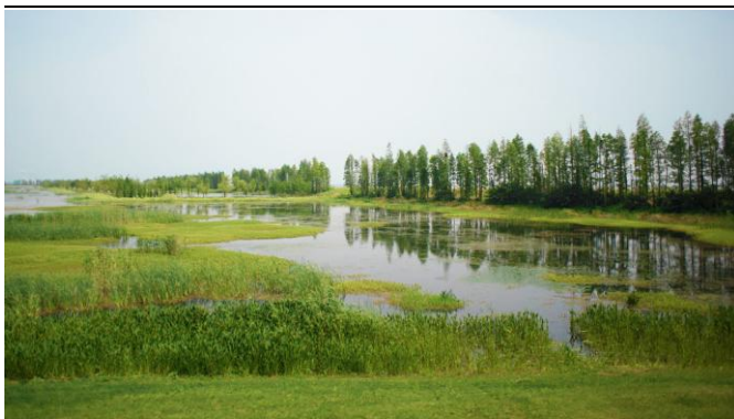
图 4：太湖湿地生态修复和保护示范工程
