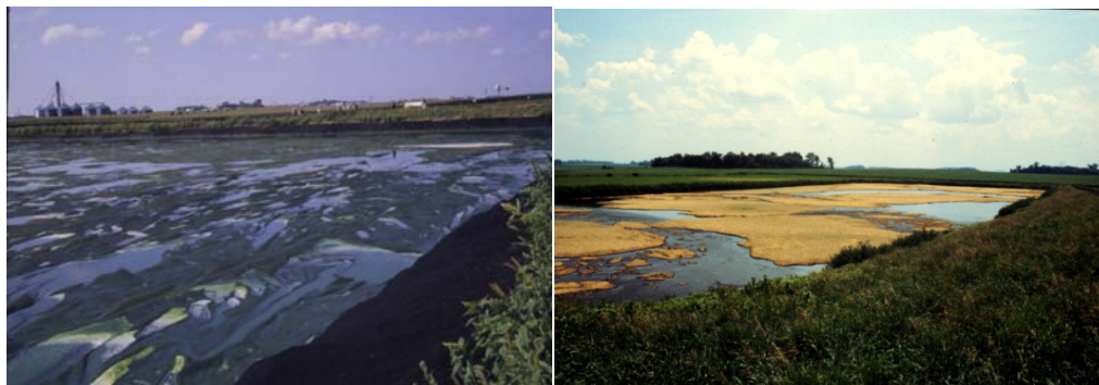
图 8-5 污水贮存覆膜处理
