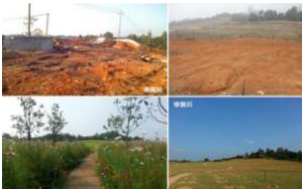
图 14：四川某镉污染土壤修复工程
