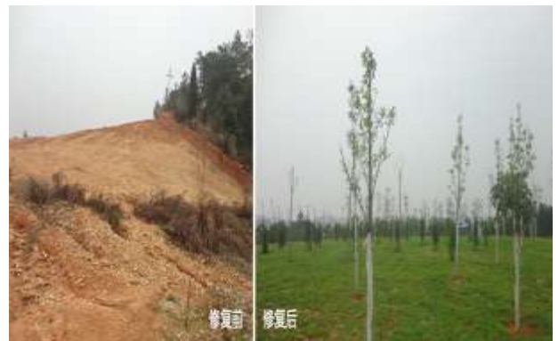
图 15：湖南某镉污染场地修复工程
