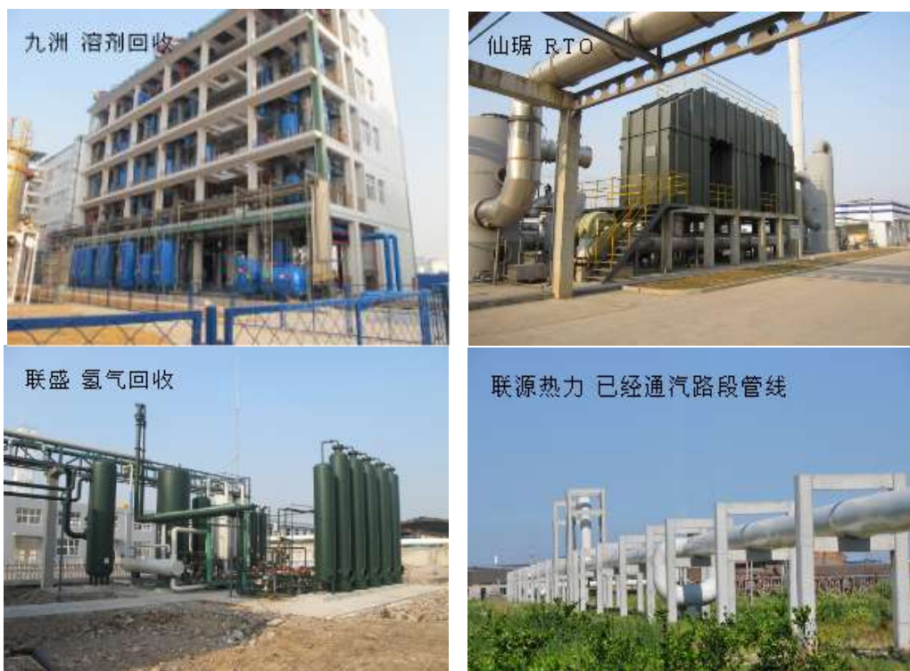
图 5—5 园区循环化改造重点支撑项目现场
