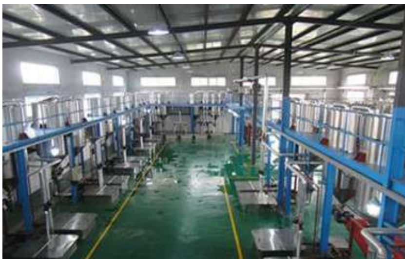
图 5—8 绿能公司餐厨废弃油脂处理工程
